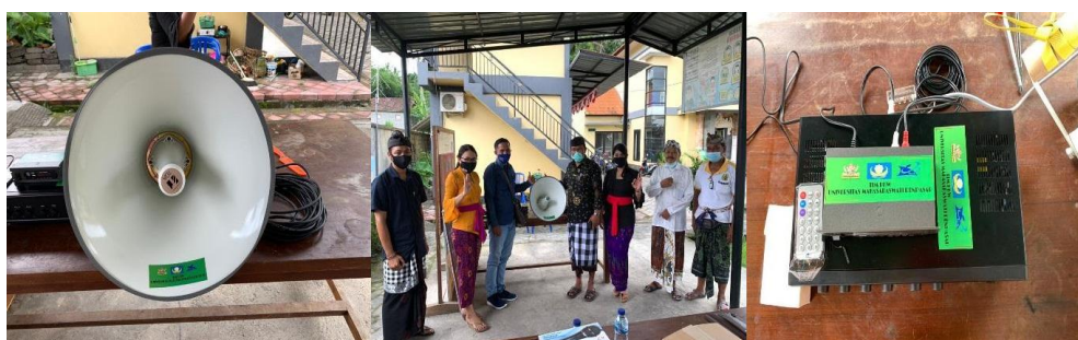
Gambar 2. Pemasangan pengeras suara di pasar Bebandem
