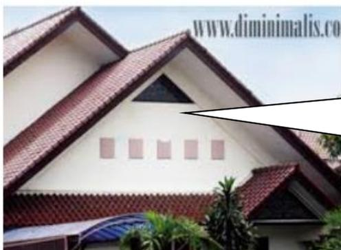
lubang ventilasi untuk sirkulasi udara sehingga secara alami udara panas atap akan keluar dan udara lebih dingin akan masuk
