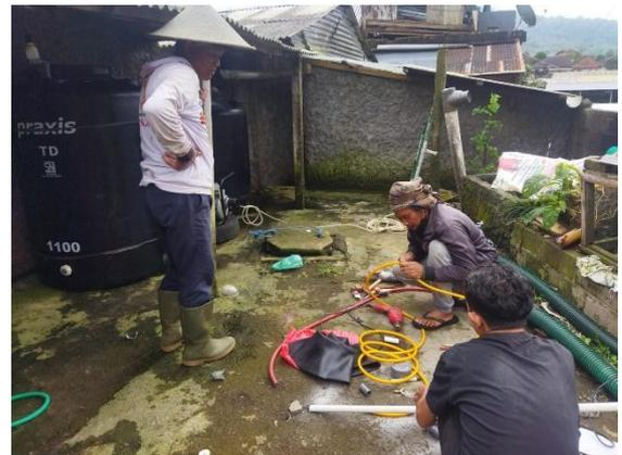
Gambar 4. Pembuatan dan pemasangan bioreactor biogas dengan volume 250 liter.
