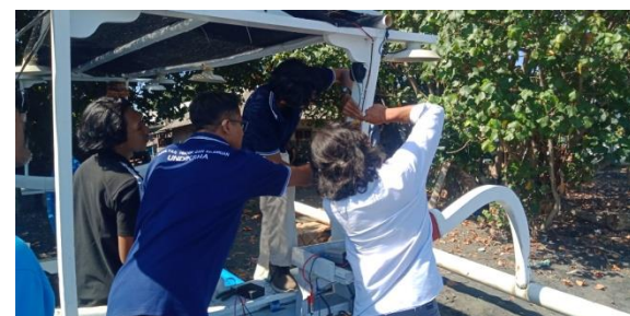
Gambar 9. Pemasangan instalasi lampu listrik
