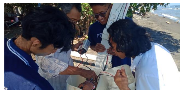
Gambar 10. Pemasangan rangkaian inverter
