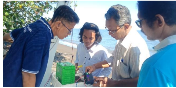
Gambar 8. Pemasangan solar charge controller
